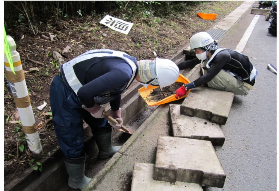
U型側溝の堆積土砂除去
