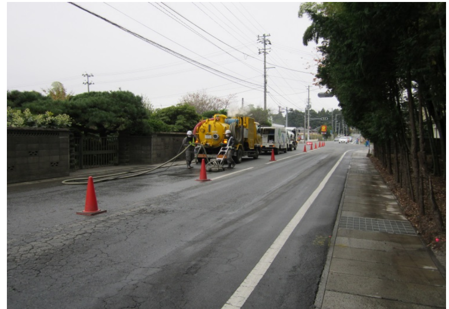
高圧洗浄作業
