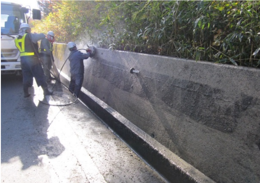
高圧洗浄作業
