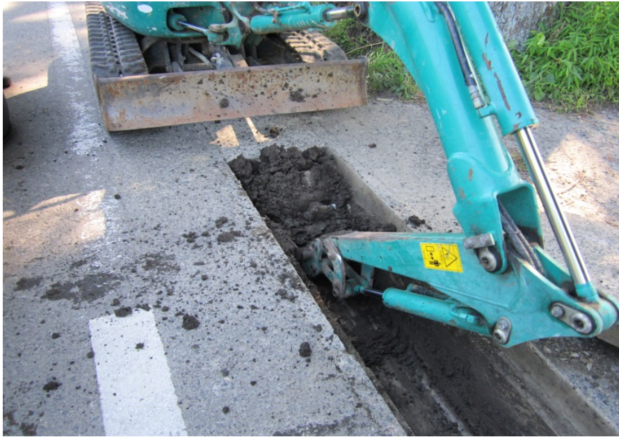
U型側溝の堆積土砂除去
