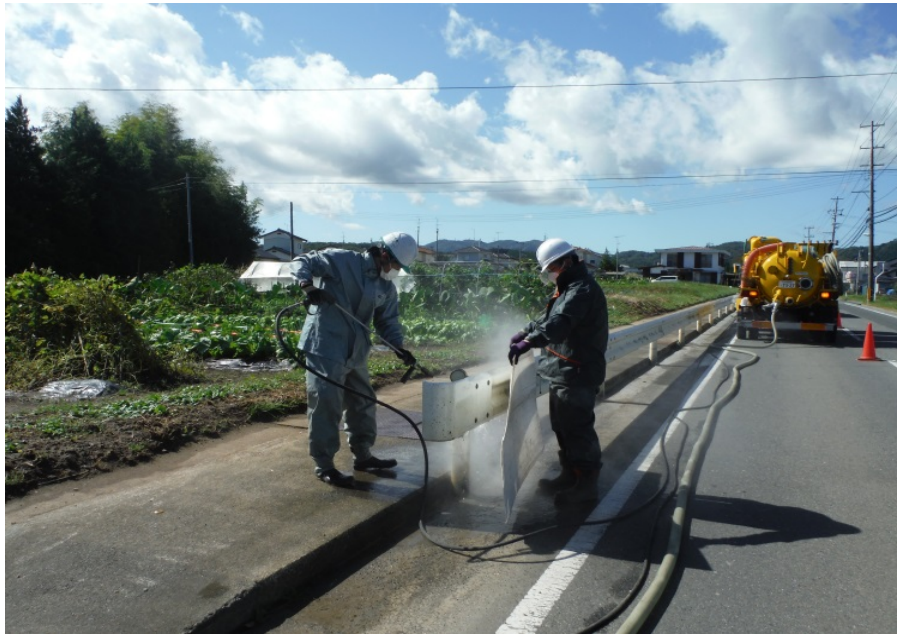
高圧洗浄作業
