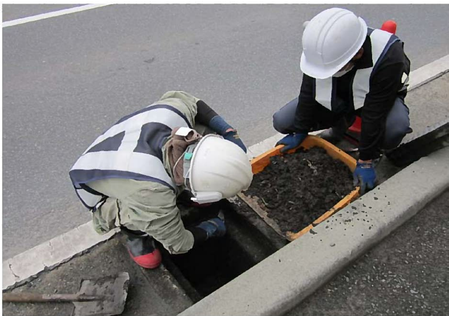
U型側溝の堆積土砂除去
