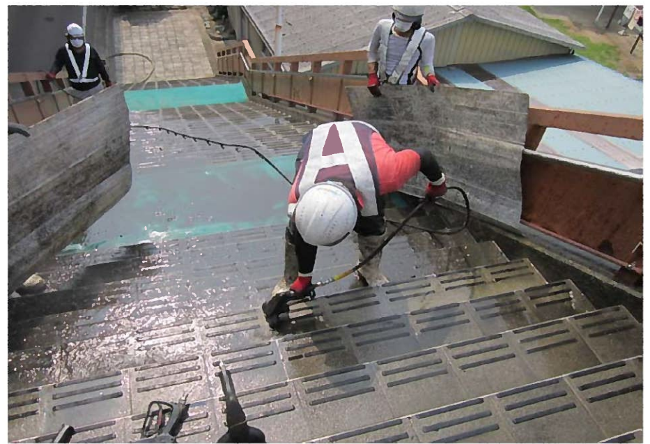
高压洗浄作業
