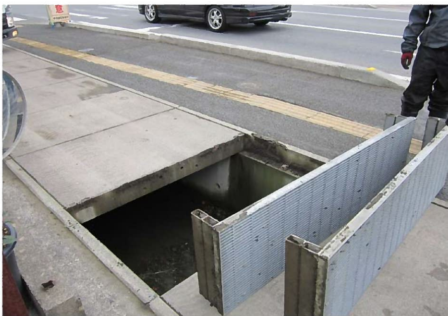
U型側溝の堆積土砂除去
