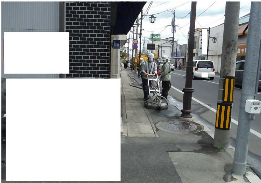
高压洗浄作業
