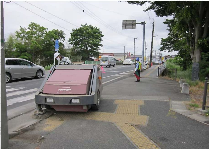
高圧洗浄作業
