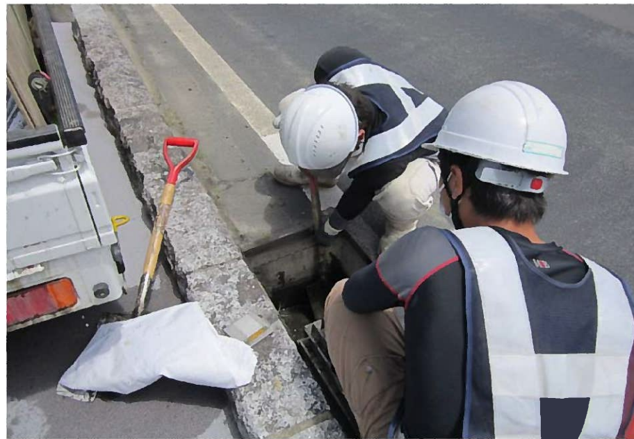
U型側溝の堆積土砂除去
