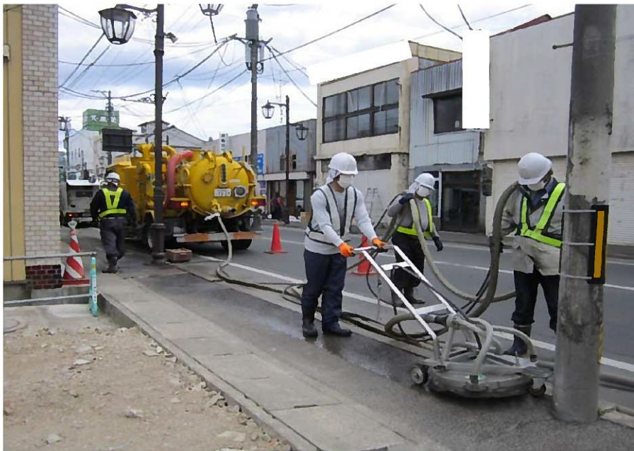
高压洗浄作業
