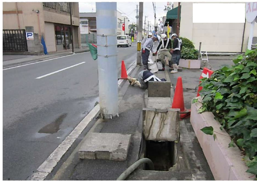
U型側溝の堆積土砂除去
