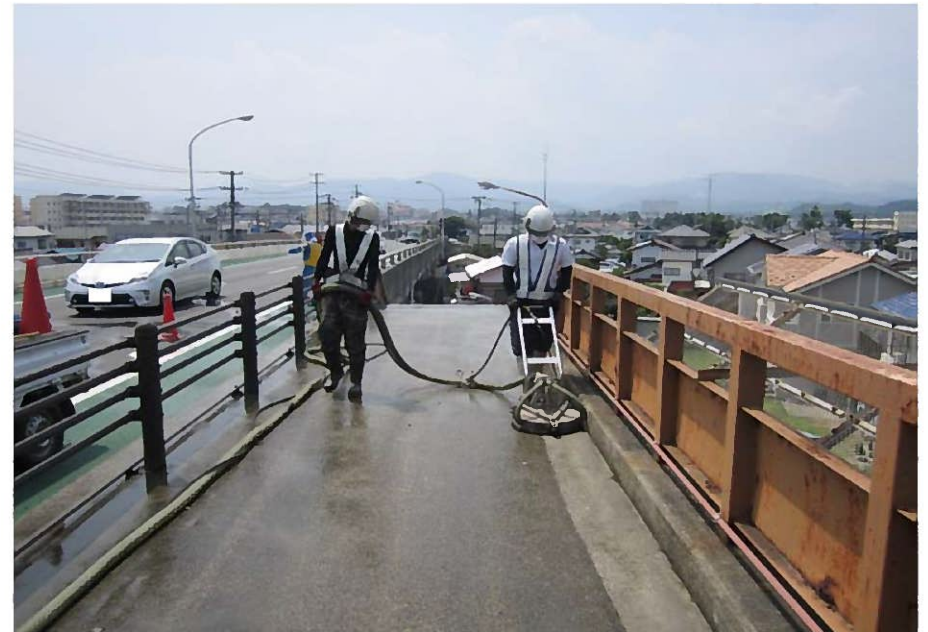
高圧洗浄作業
