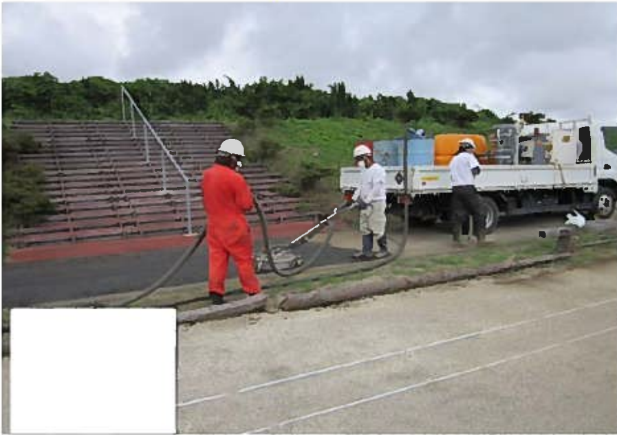
吸引型高圧機による除染作業
