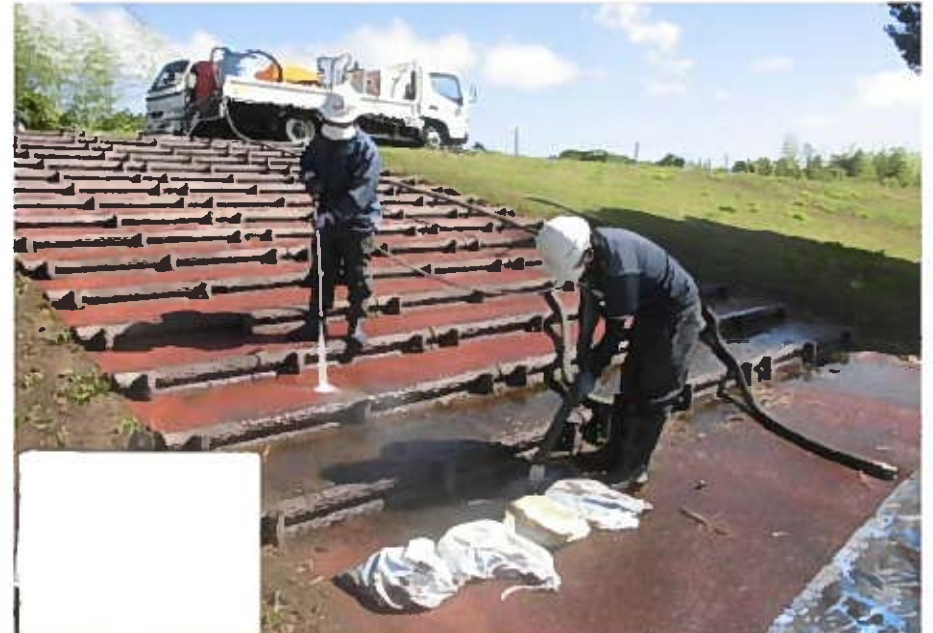
高圧洗浄作業
