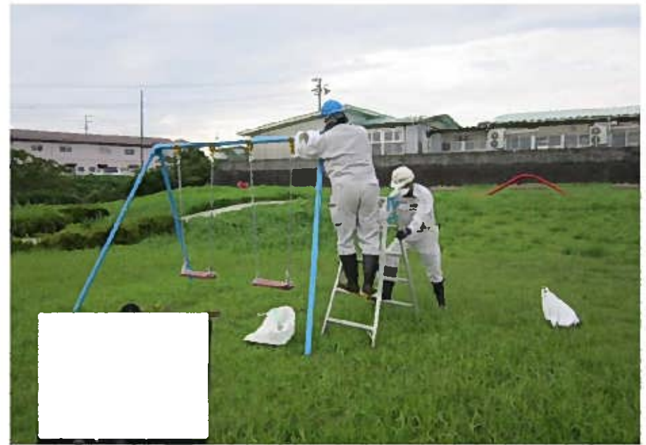
拭取り除染作業
