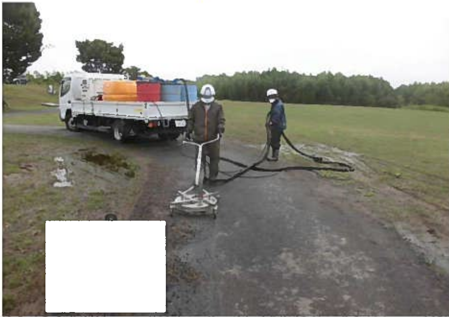
吸引型高圧機による除染作業
