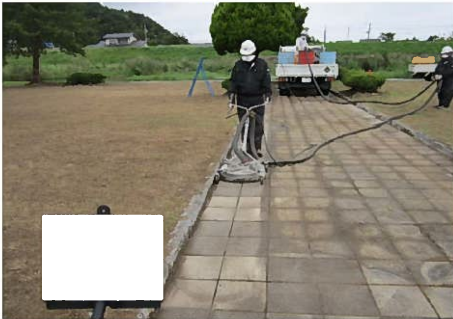
吸引型高圧機による除染作業
