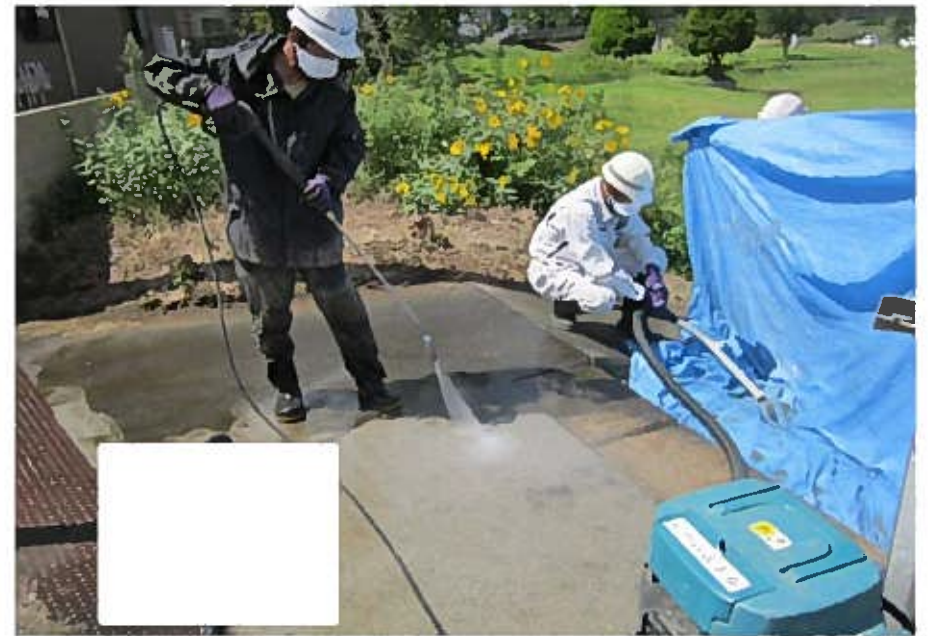
高圧洗浄機による除染作業
