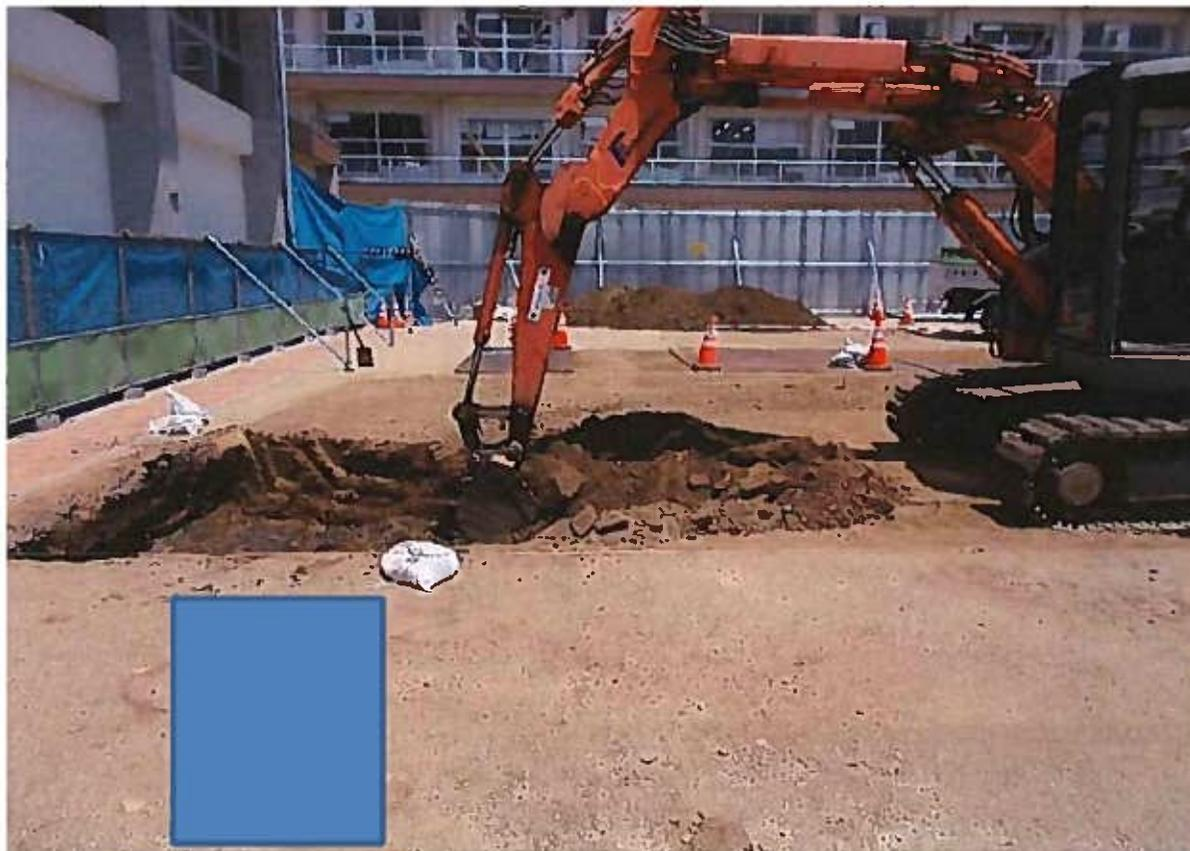
4 保護マット（3層）を裁断し、フレコンバッグに収納し撤去する。
