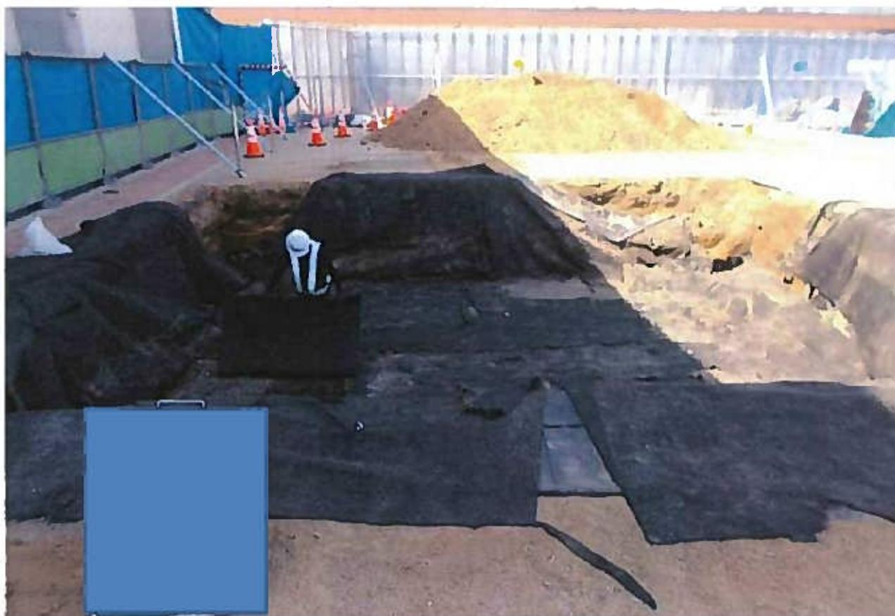
7 掘削した個所を新しい山砂（山砂の空間線量測定）で埋め戻す。
