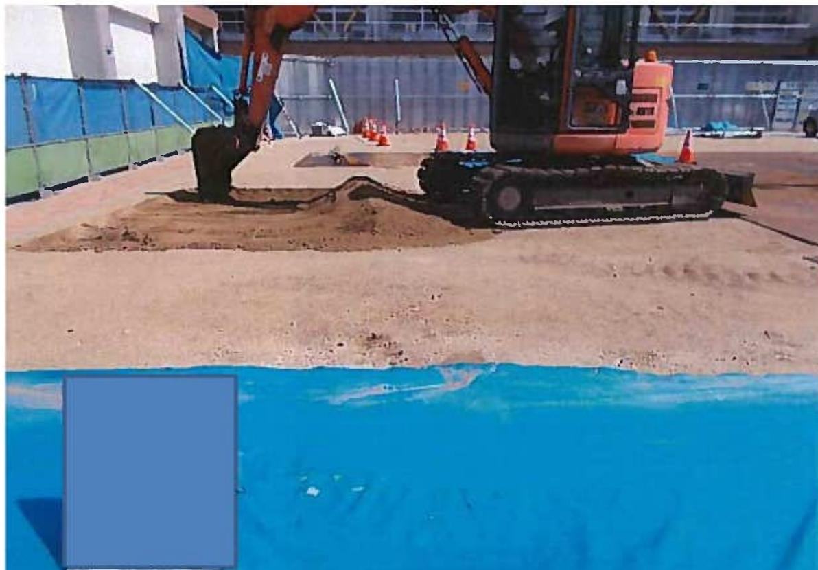
3 覆土（遮蔽土）H=800cmを重機を使い掘削し、隣接場所に運搬する。
