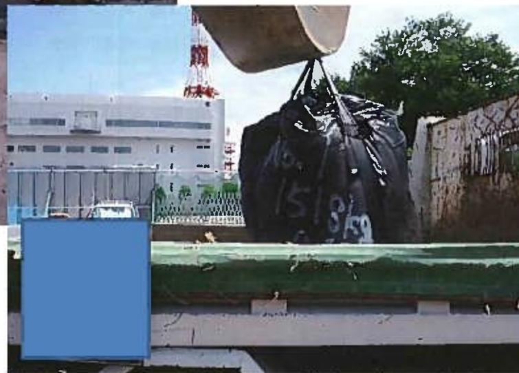
6 側面、及び底面の保護マットを裁断し、フレコンバッグに収納し撤去する。
