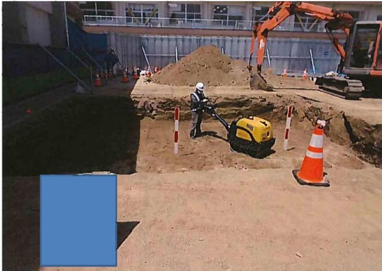
9 塩化マグネシウム (1kg/m<sup>2</sup>) を用いたクレイ舗装H=3cm
