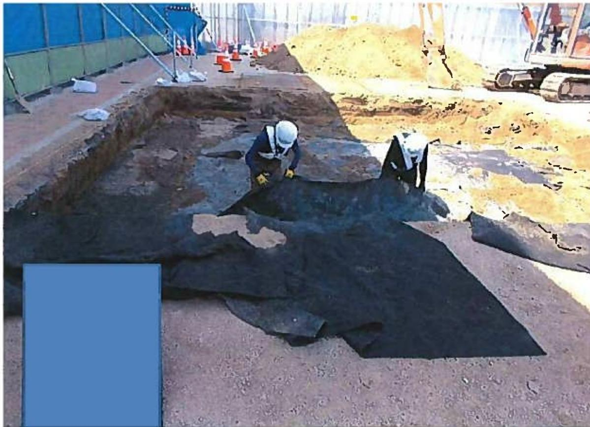
5 除染土を掘削し、フレコンバッグに収納しダンプにて仮置場に搬入する。
