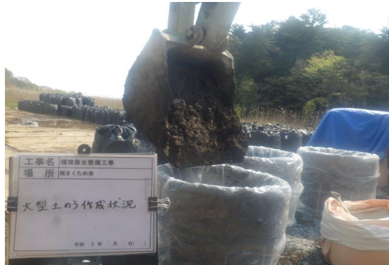
⑩大型土のう袋詰め状況
