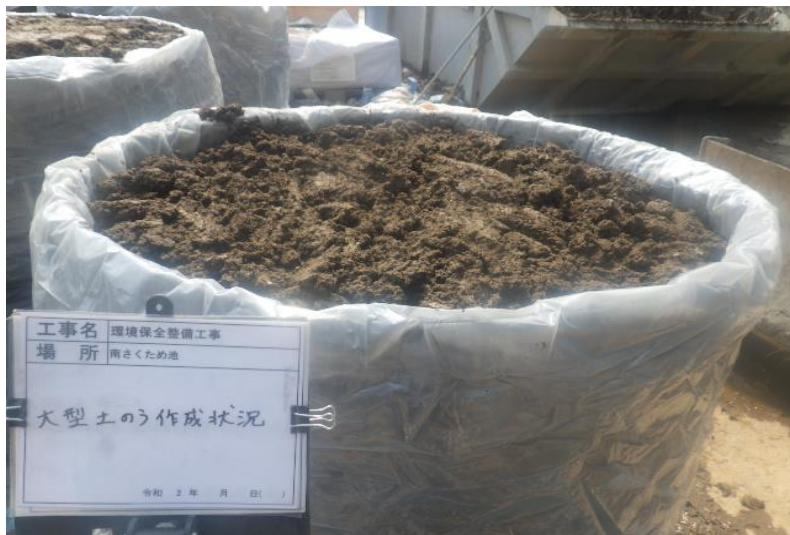
⑪大型土のう袋詰め状況
