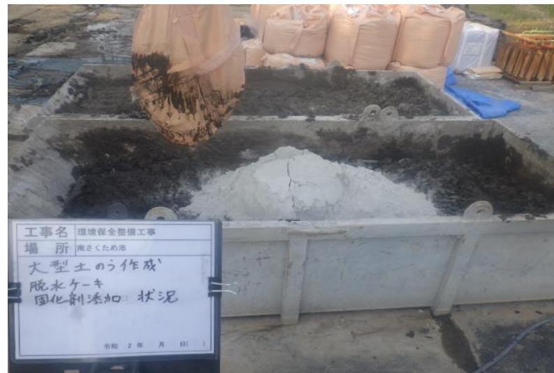
⑧脱水ケーキ 固化剤添加状況
