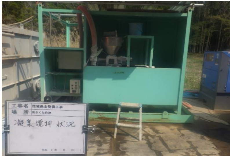
⑤凝集攪拌状況
