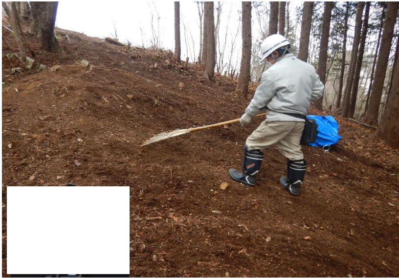
除染作業（表土剥ぎ：堆積物除去）
