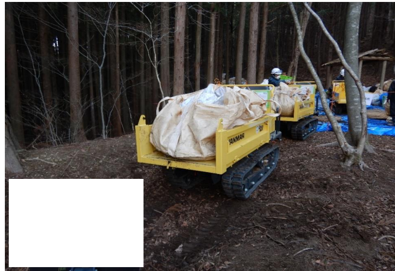
場内運搬状況
