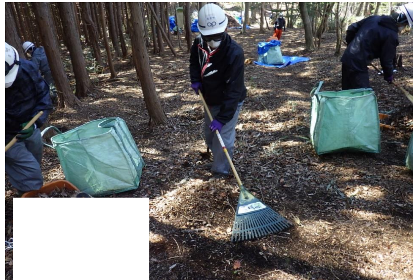
除染作業（表土剥ぎ：堆積物除去）
