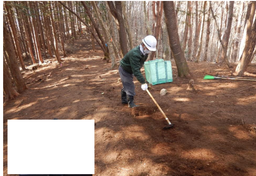
除染作業（表土剥ぎ：堆積物除去）
