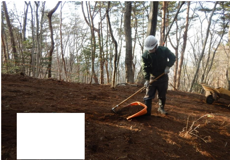
除染作業（表土剥ぎ：堆積物除去）
