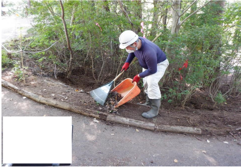
除染作業（表土剥ぎ：堆積物除去）
