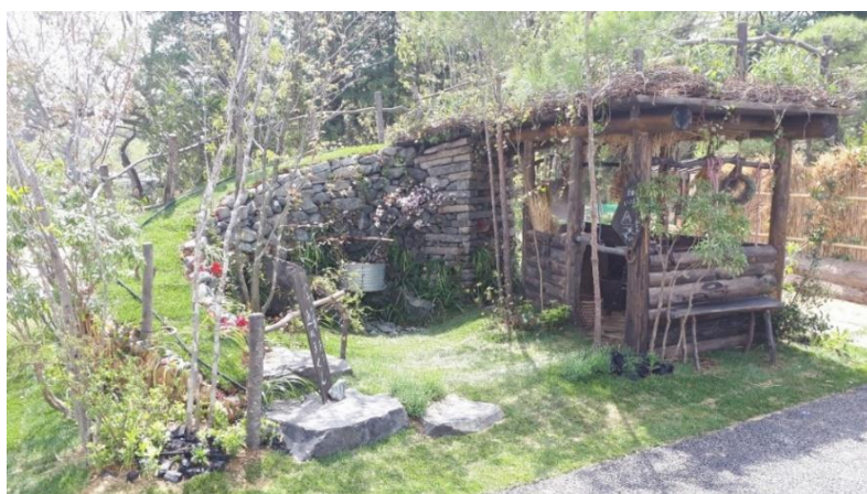
完成写真（R5.4.14撮影）
